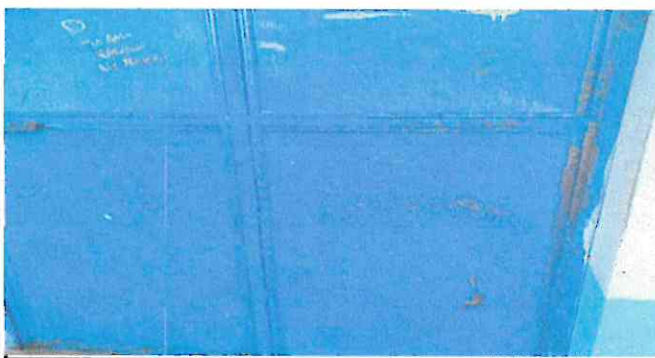
Pintura en puertas de los salones
