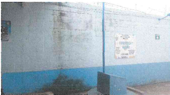
Pintura en la parte interior
